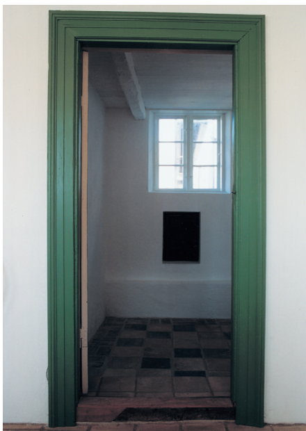
Mælkekælderen. Kaseinkalket plankeloft.
